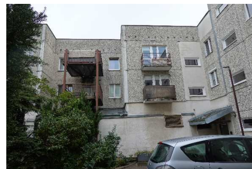
Elewacja zachodnia (od podwórza), część 1
