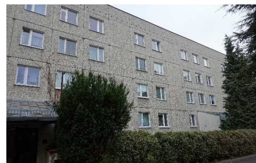
Elewacja północna i wschodnia (od podwórza), część 2
