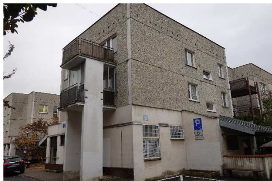
Elewacja północna (szczytowa) i zachodnia (od podwórza), część 1
