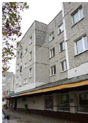
Elewacja północna (od ul. Romera), część 3
