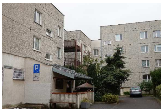
Elewacja zachodnia (od podwórza), część 1
