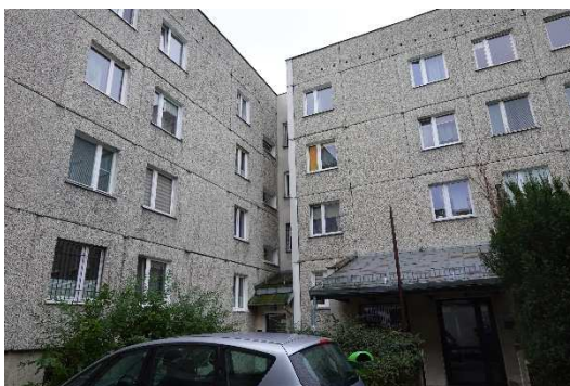
Elewacja północna i wschodnia (od podwórza), część 2
