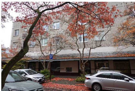
Elewacja wschodnia, od ul. Janowskiego część 1
