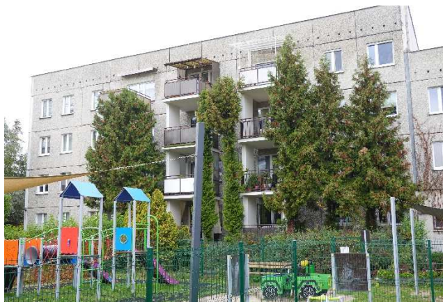
Elewacja południowa, część 2
