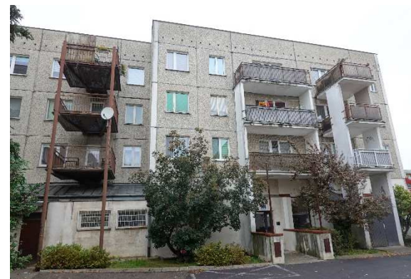
Elewacja południowa, część 3
