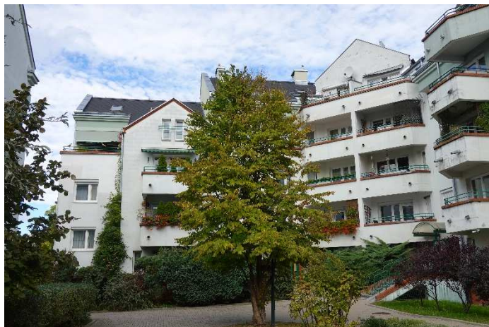
Elewacja południowo-wschodnia i południowa – od podwórza
