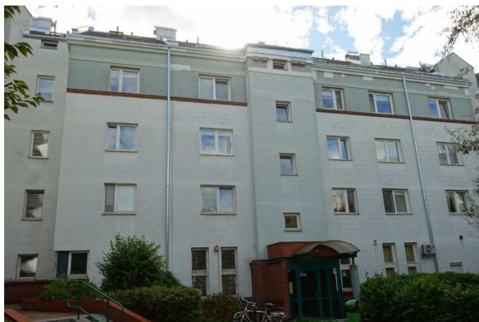
Elewacja północno-zachodnia – od podwórza
