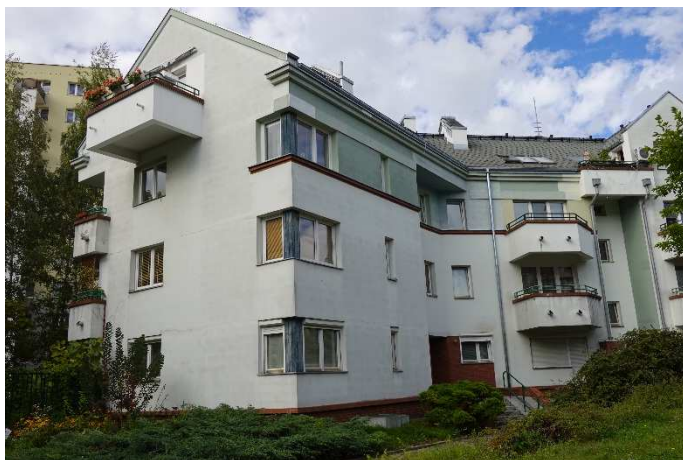
Elewacja południowo- wschodnia i wschodnia – od podwórza
