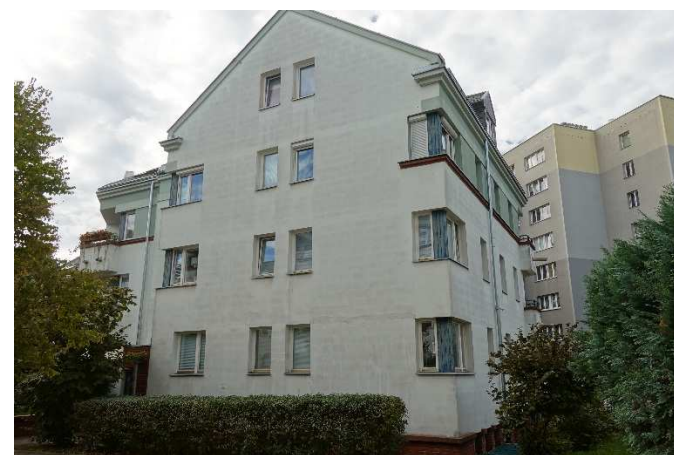
Elewacja północno-wschodnia – od podwórza
