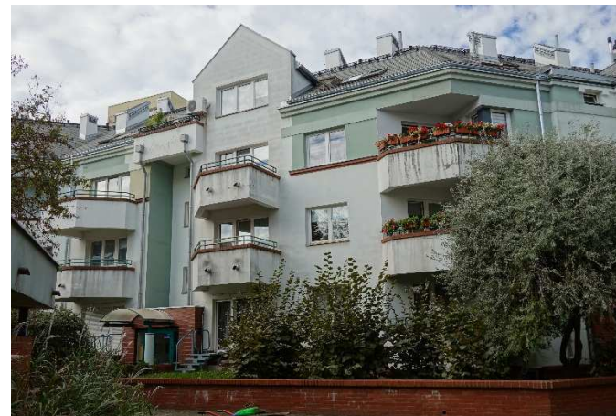
Elewacja wschodnia – od podwórza
